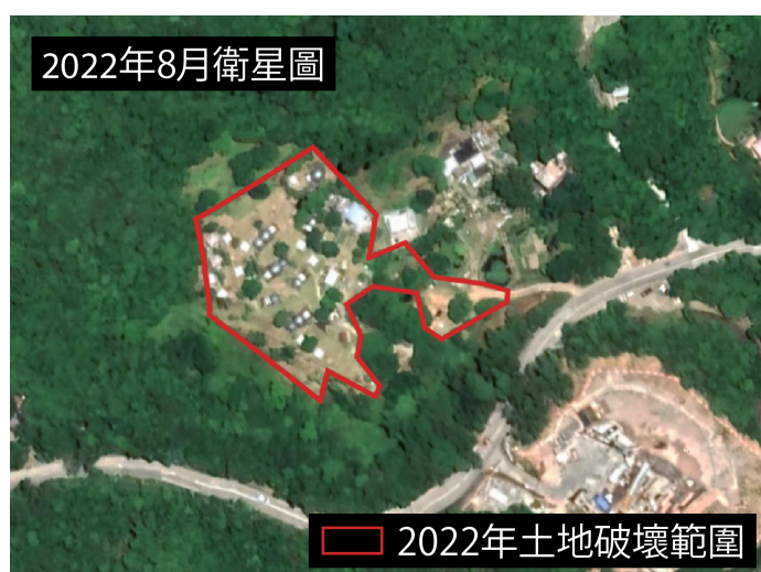
圖4:所在地:貝澳 到了2022年, 該土地被廣泛倒泥建設。
